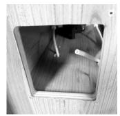
下段を設置し、上段キャビネットを正しい位置に合わせたら付属のボルトナット(助手席側だけ皿ボルト)で本固定します。ボルトを上段キャビネットから通して下段キャビネット側にワッシャーを挟みナットで押さえます。しっかりと固定されたら最後にエンドキャップ型のナット(怪我防止の保護キャップ)を装着してください。◆上段と下段の位置合わせ(調整)が重要です。
